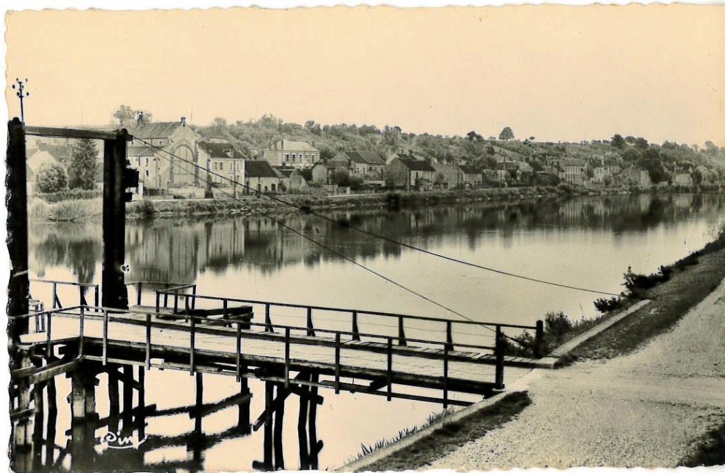
L'ancien pont sur l'Yonne bombardé en 1944 (coll. Karl Guillot) et la passerelle provisoire qui l'a remplacé (cliché DIM). Vue vers l'amont - rive droite- en direction de Migennes
